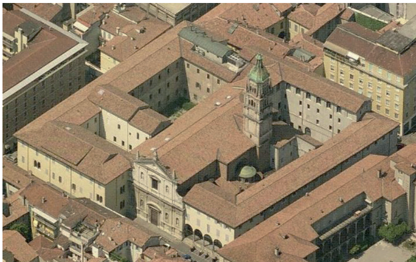
Il campanile di S. Pietro prima dei restauri, veduta aerea
