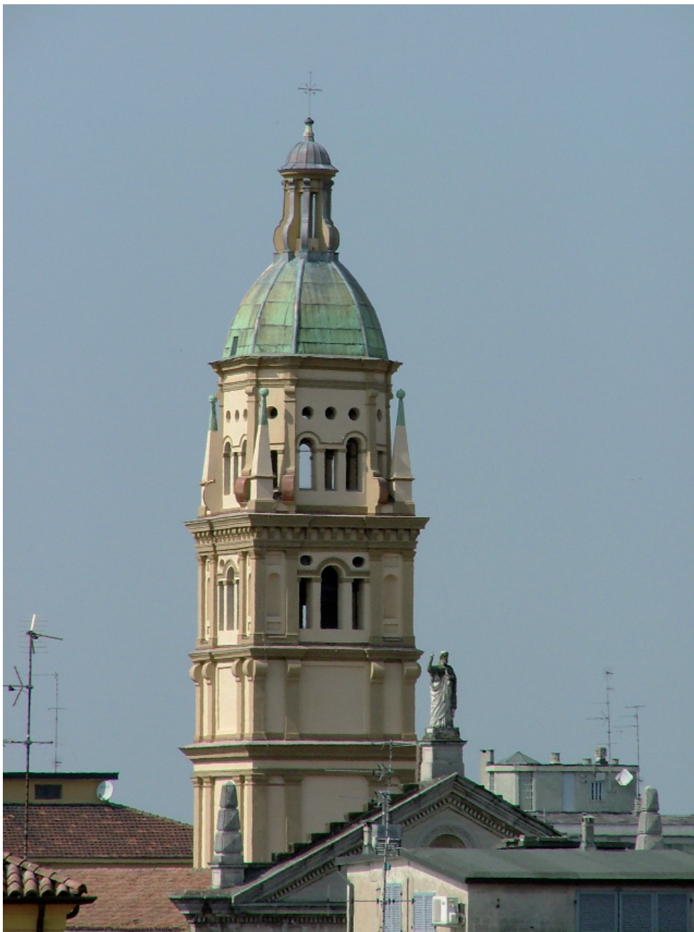
La torre campanaria dopo l'intervento di restauro
