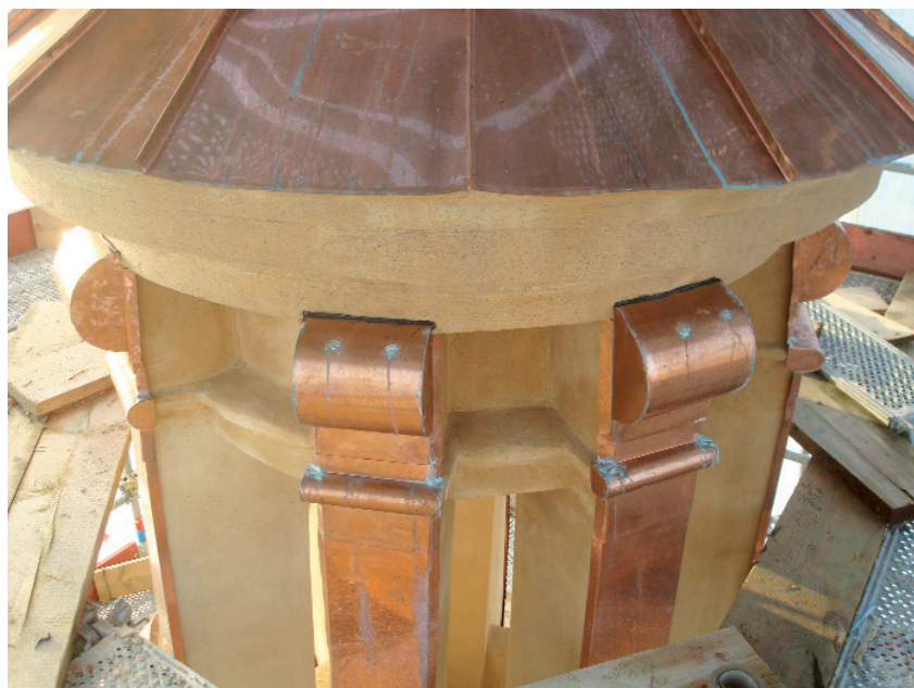
Protezione della lanterna in lamina di rame
