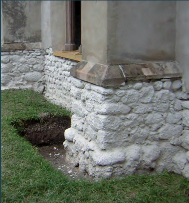
Malta da rinzafo antisale di calce e pozzolana
