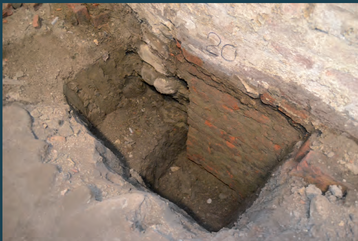
Campionatura di scavo del cavedio aerato
