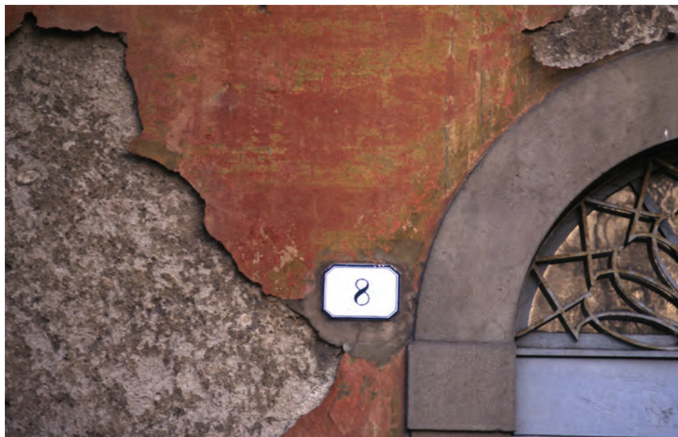
Intonaco su fondo di cocciopesto e velatura superficiale rosso su giallo
