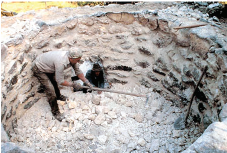
Lo scarico della calce viva
