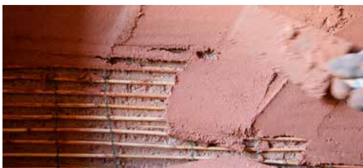
Intonacatura di cocchiopesto su cannicciato
