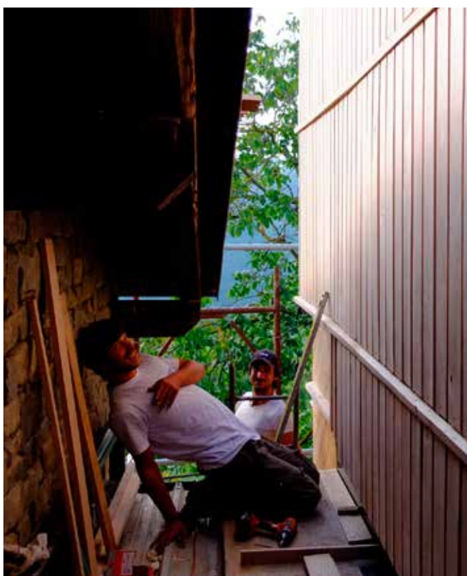
Posa del rivestimento in castagno
