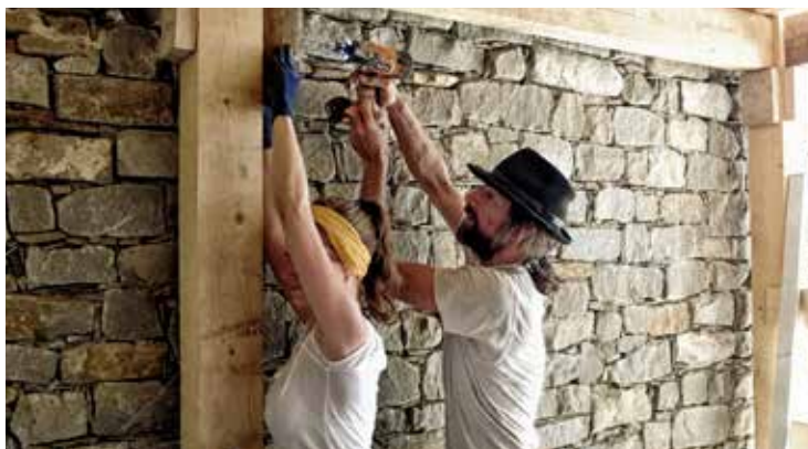
Montaggio della struttura in legno
