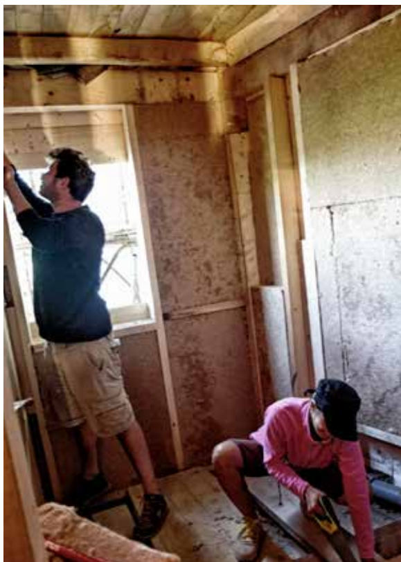
Posa della coibentazione in fibra di legno
